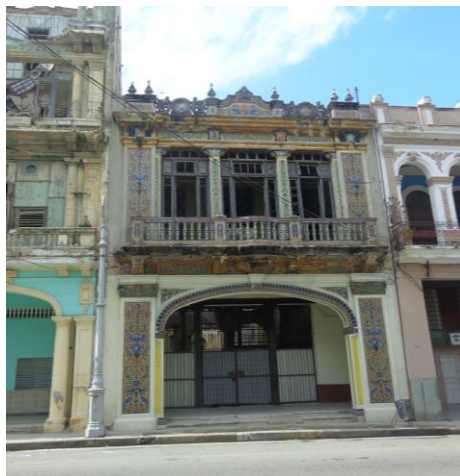
Edificio Galiano. Patrimonio Mural en fachada (azulejos)
